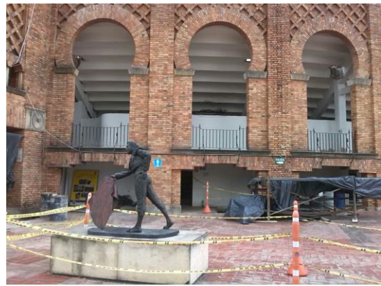
Cerramiento para protección de monumentos en la plataforma de acceso
