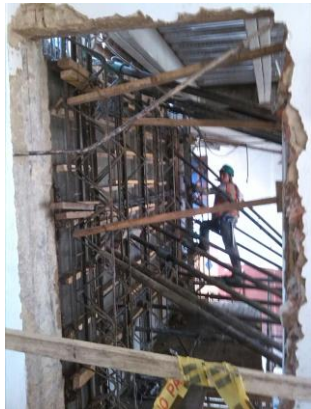
Formaleta muro pantalla
