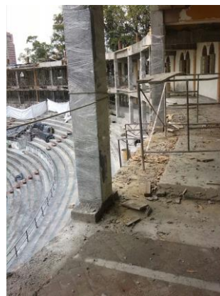
Columnas, vigas, cubierta y losa de entpiso para palcos
